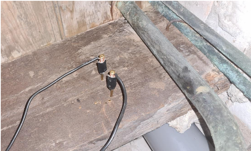
Foto 3 meetsensoren aangebracht in de houten balk
