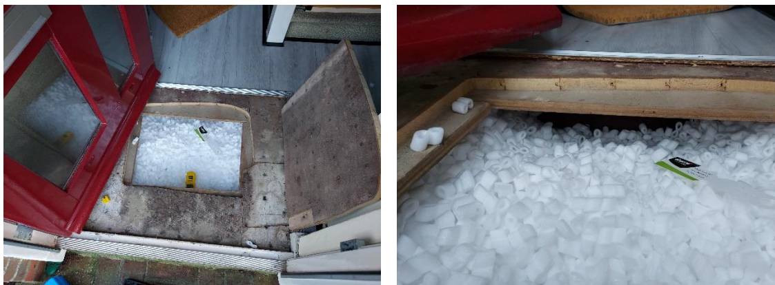
Foto 4 en 5, kruipruimte volledig gevuld met Drowa chips
